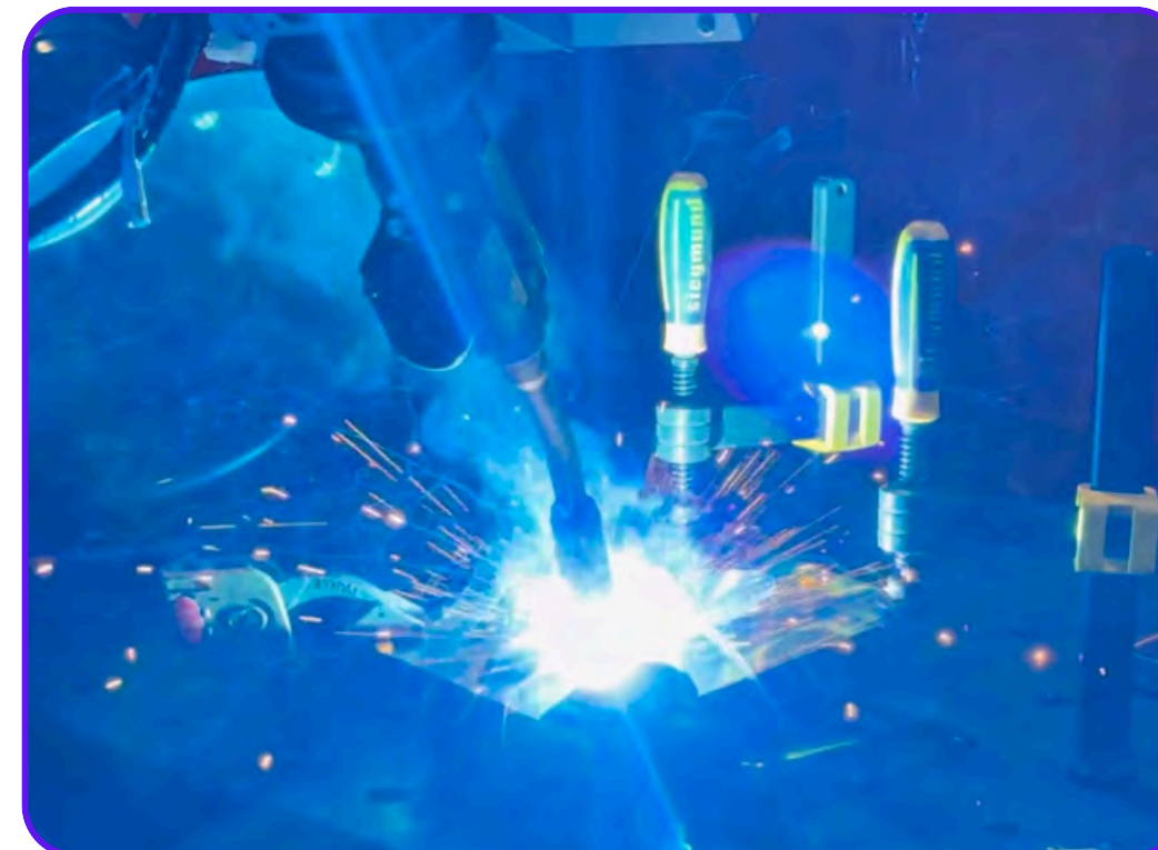
Réparation de défauts automatisée par soudage sur acier inoxydable et caractérisation d'un rechargement partiel
